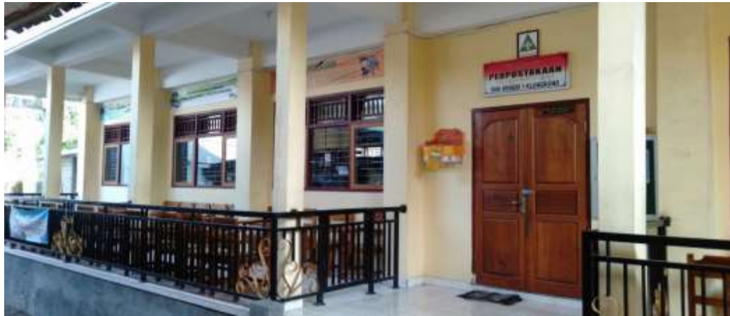
Gambar 1. Tampak depan Gedung Perpustakaan SMK N 1 Klungkung (sumber: Dokumentasi Pribadi Giri,2022)
