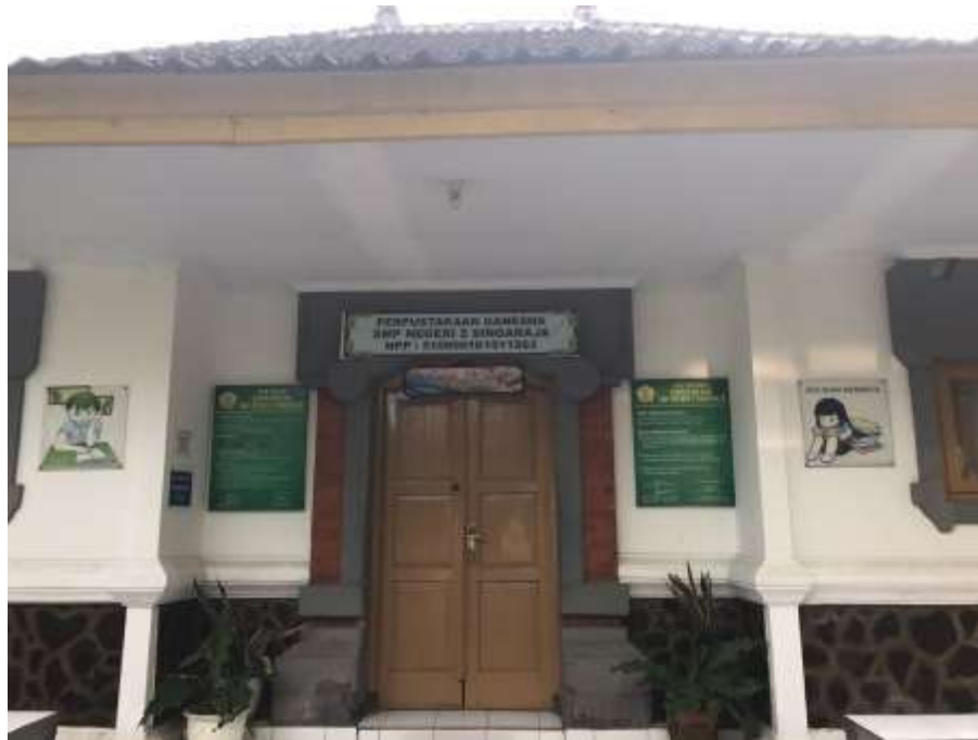
Gambar 1. Gedung Perpustakaan SMP Negeri 2 Singaraja (Sumber: Dokumentasi Pribadi Pasek,2022)
