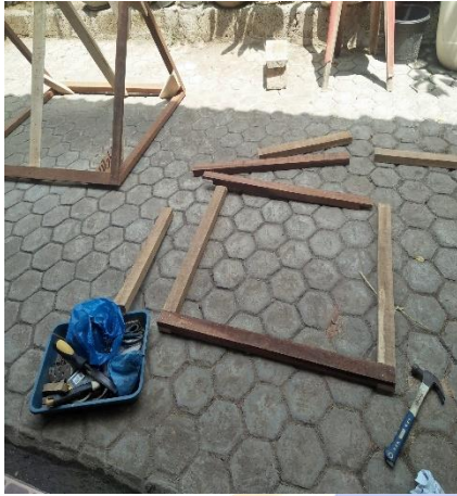
Gambar 1 Pembuatan Rangka dudukan Panel Surya
