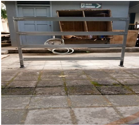
Gambar 5. Tahap Pembuatan Kedudukan Komponen
