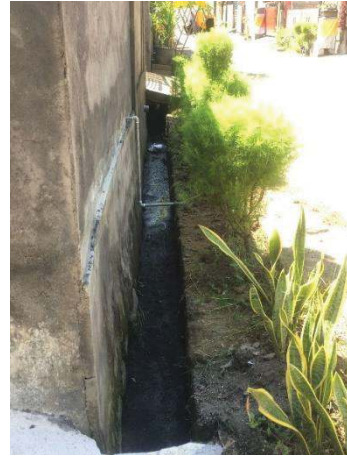
H. Sanitasi kondisi baik
