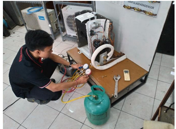
Gambar 6. Proses vakum dan pengisian refrigeran R22
