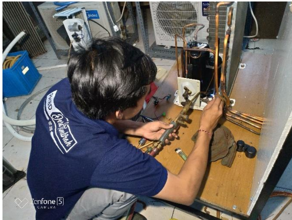
Gambar 5. Proses pengelasan pipa tembaga menuju Sight Glass
