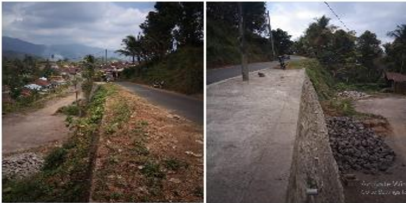
FOTO KONDISI JALAN PEMASANGAN PAGAR PENGAMAN RUAS JALAN TUKAD BAKAH – KEDIS
