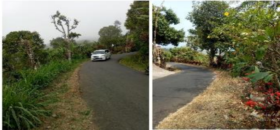
FOTO KONDISI JALAN PEMASANGAN RAMBU LALU LINTAS DAN CERMIN TIKUNGAN RUAS JALAN SELAT - ASAH GOBLEG
