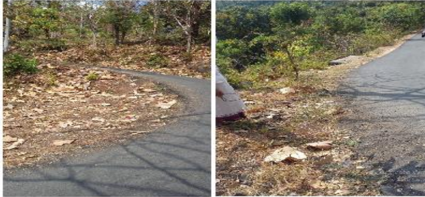
FOTO KONDISI JALAN PEMASANGAN RAMBU LALU LINTAS DAN CERMIN TIKUNGAN RUAS JALAN KALIASEM - TIGAWASA
