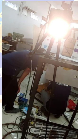
Gambar 4 Tahap Pemasangan lampu sorot untuk pencahaan
