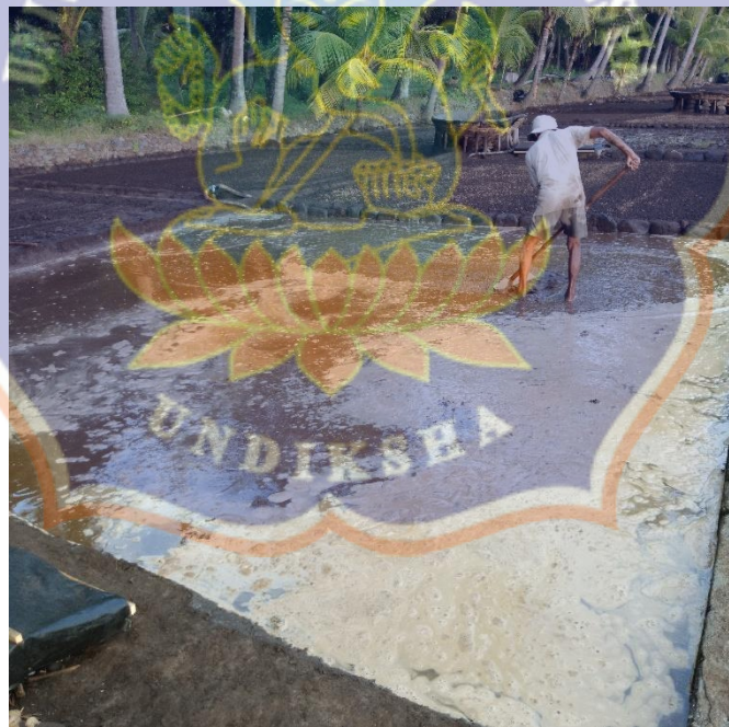
Gambar 6.19 Mengaduk Tanah Pilihan Menggunakan Tulud
