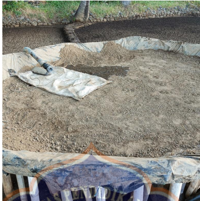
Gambar 6.32 Menuangkan Air Laut ke Atas Tinjung
