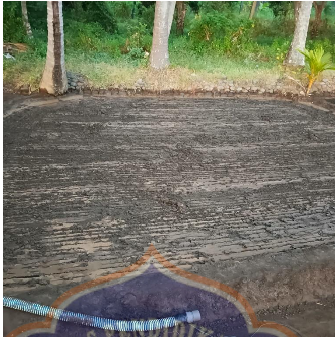
Gambar 6.12 Tanah Pilihan yang Sudah Diaduk Menggunakan Bangkrak dan Tulud
