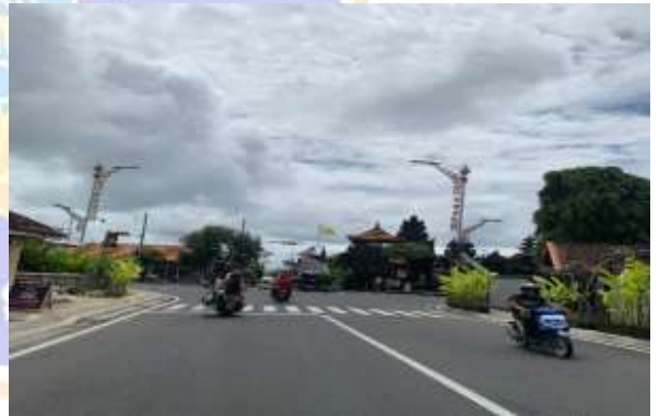
Kondisi tanah yang telah dilakukan pelebaran jalan di Nusa Dua
