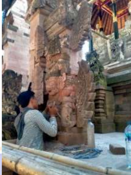
Gambar 5.19 Proses Penggarapan Eestorasi Patung Wilmana Pada Candi
