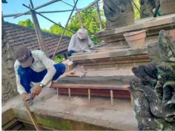
Gambar 5.21 Pemasangan Batu Padas Pada Undag Pelinggih
