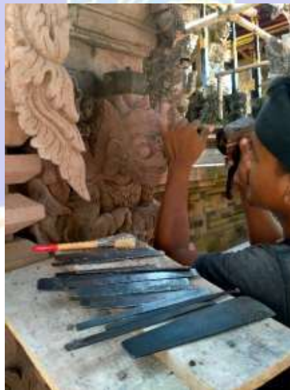
Gambar 5.18 Proses Penggarapan Restorasi Patung Bhuda Tantra Pada Candi
