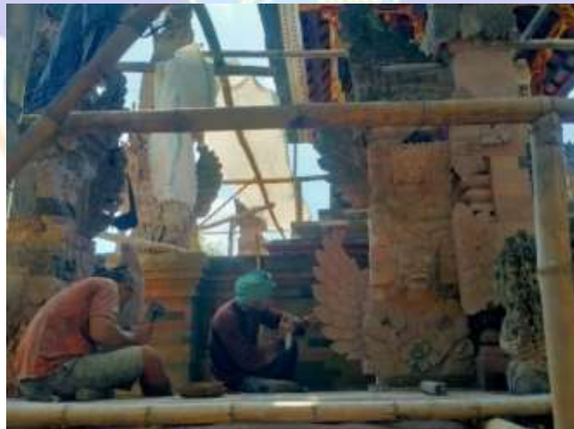
Gambar 5.20 Proses Memperjelas Ornament Batu Padas Pada Candi-Candi
