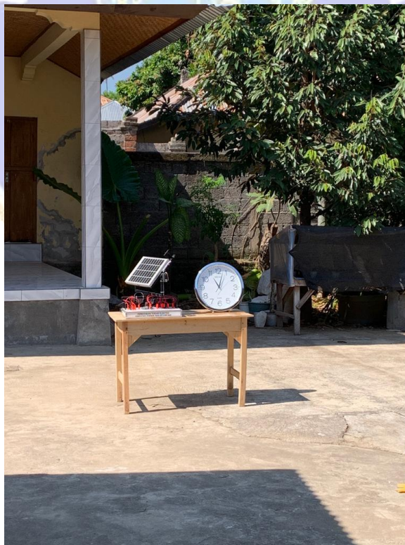
Pengujian Tracking Solar Cell
