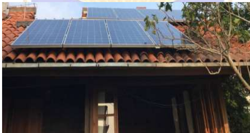
Gambar 3. 4 Pemasangan Photovoltaic
