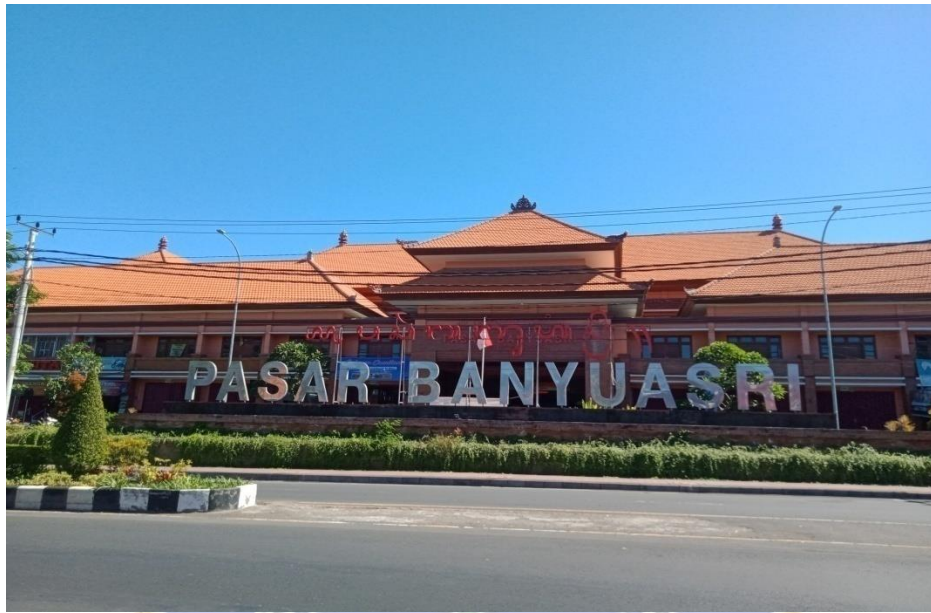
Gambar 21 Tampak depan pasar banyuasri
