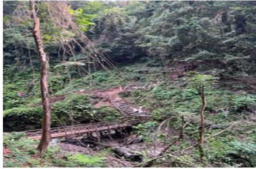
Gambar 1. 2 Jembatan menuju titik Tengah
