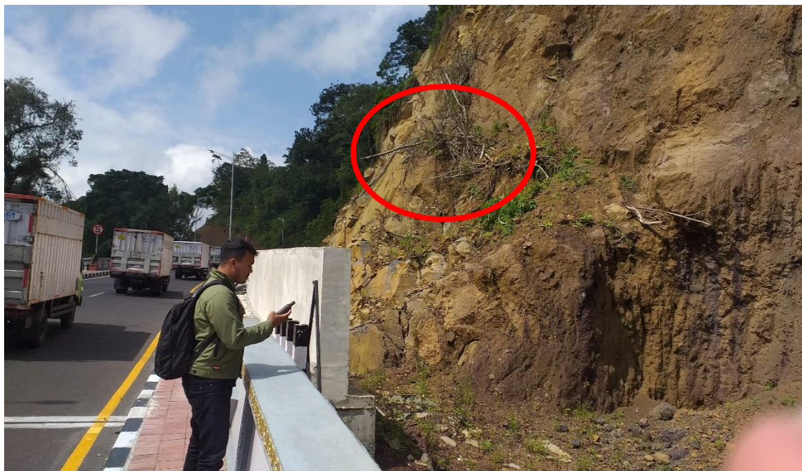
Gambar Situasi dilapangan diwilayah Desa Candikuning
