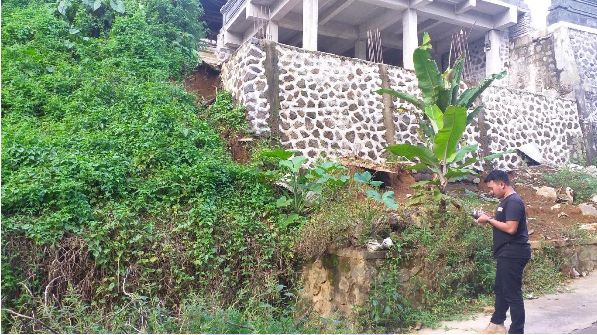
Gambar Situasi dilapangan diwilayah Desa Peraan
