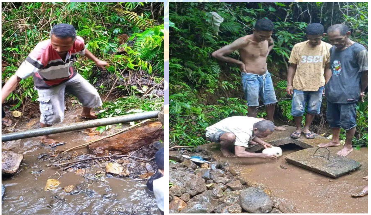
Gambar 2. Pembersihan bak penampung Air Baku Mata Air Wua Pi'I (Sumber: Dokumentasi Juang, 2024)
