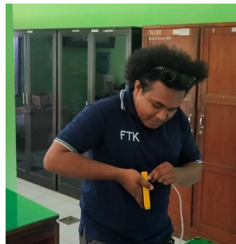
Krimping Kabel Untuk menghubungkan Modem TU dan Mikrotik
