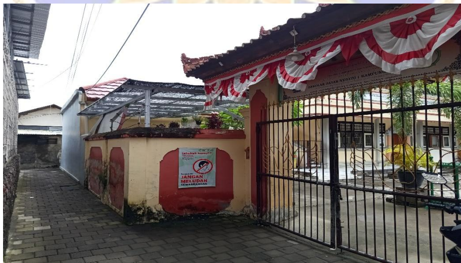
Jalan Masuk SD 1 Kampung Bugis
