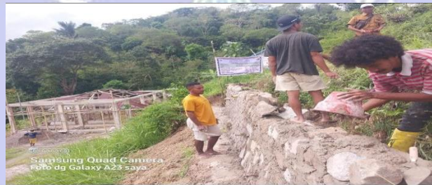
Gambar 7. Foto pembangunan TPT
