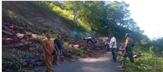
Gambar 6. Foto lokasi longsor desa Perak
