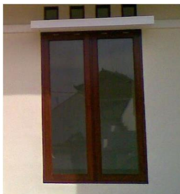
Gambar 2. 4 Kaca pada jendela
