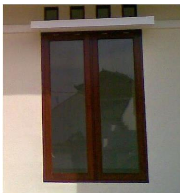
Gambar 2. 4 Kaca pada jendela
