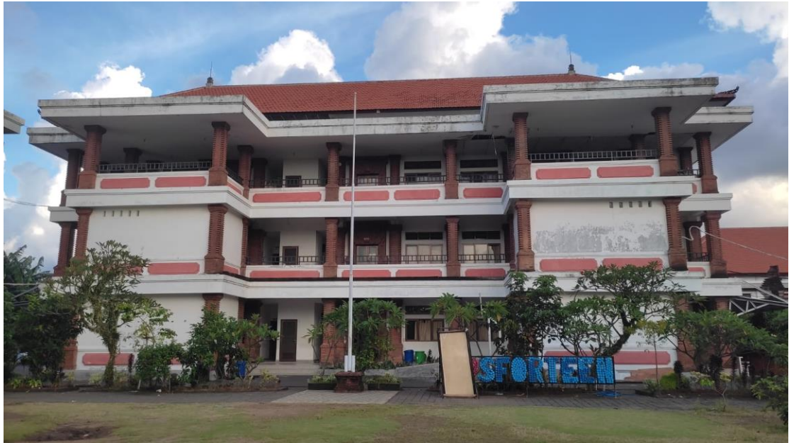
Gambar 3. Gedung Selatan SMP Negeri 14 Denpasar
