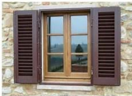
Gambar 7. Pemuaian Luas pada Tiang Jendela
