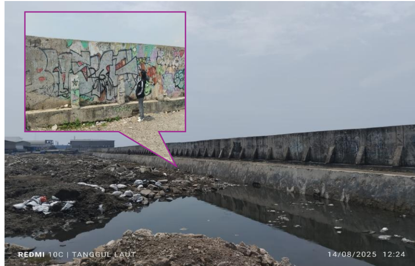
Gambar 1. 2 Kondisi Sea Wall Jakarta di Pantai Utara Jakarta terbaru 2025
