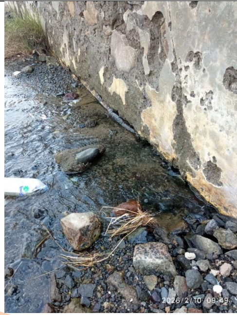
Gambar 6. Menunjukkan aliran rembesan air laut yang berasal dari dari balik tembok yang menghadap ke laut
