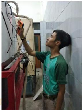
Saat melakukan pengecekan suhu jalur pipa dari *water tank supply* ke kabin
