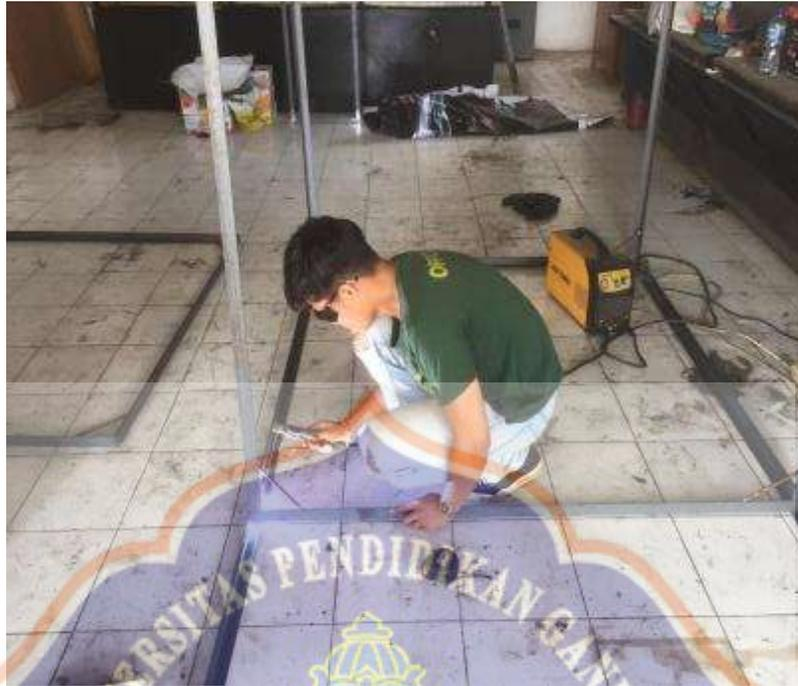
Gambar 1. Proses pengelasan pada setiap ujung besi.
