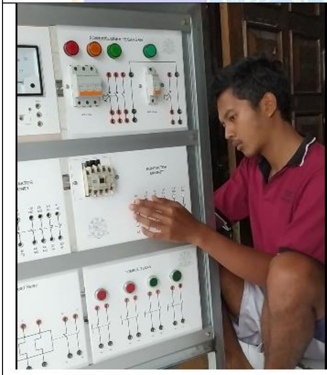
Gambar 6. Pemasangan Komponen dan Jack Banana
