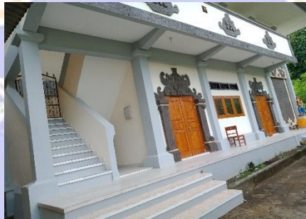
Gambar 2. Kondisi Ruang Prasarana Laboratorium
