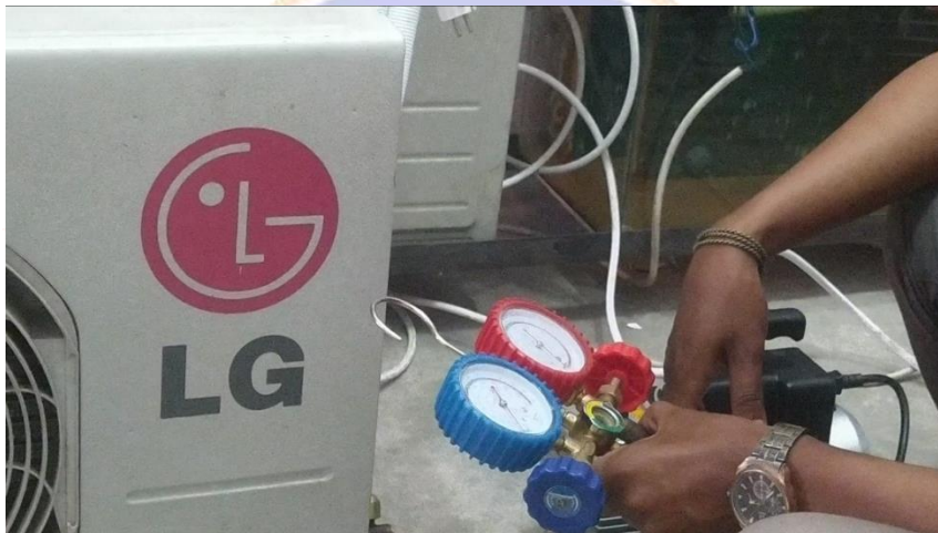
Gambar 4. Pemvakuman Unit AC Split
