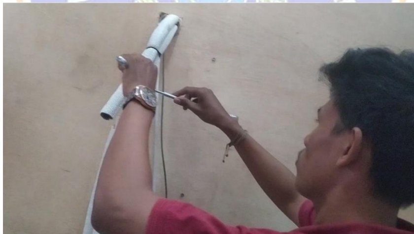
Gambar 2. Pemasangan Pipa Penghubung Pada Sisi Indoor
