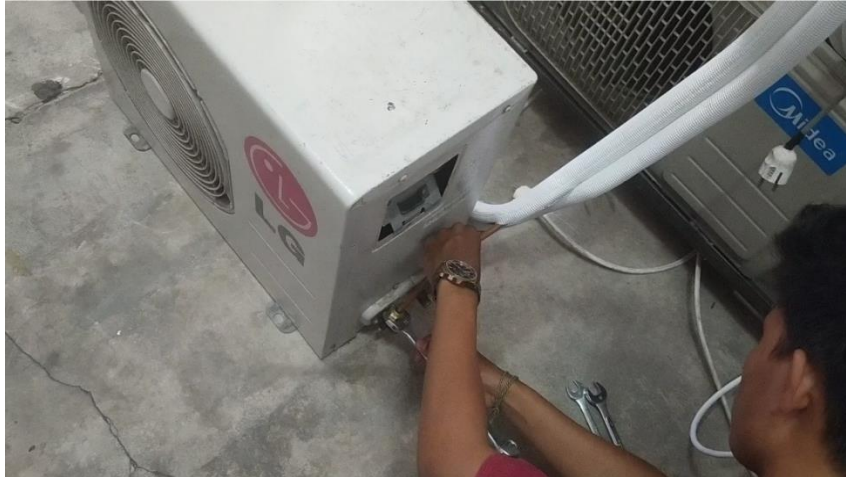
Gambar 3. Pemasangan Pipa Penghubung Pada Sisi Outdoor
