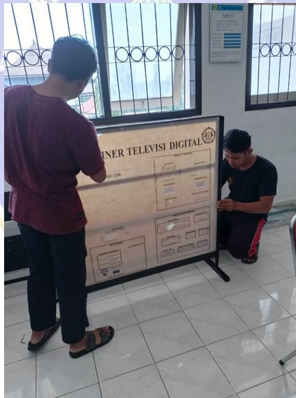
Proses Pemasangan Akrilik Pada Tiang Penyangga
