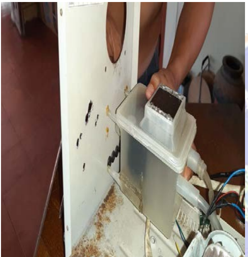
Pemasangan Reservoir dan Pompa
