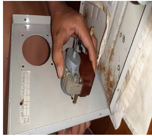
Pemasangan Motor Fan
