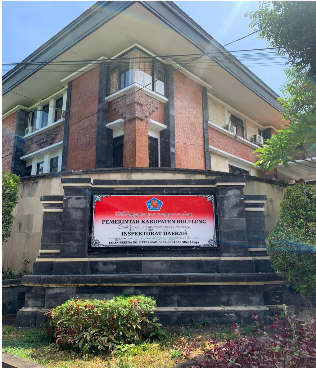
Tampilan Luar Kantor Inspektorat Kabupaten Buleleng
